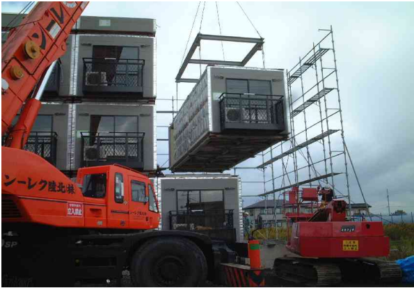
建て方施工 ユニット設置現場
